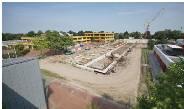
Blick auf die Baustelle vom 11.08.2021
