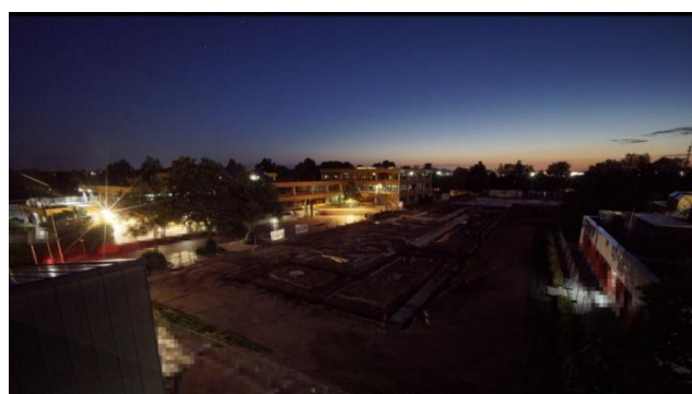
Die Baustelle bei Nacht
